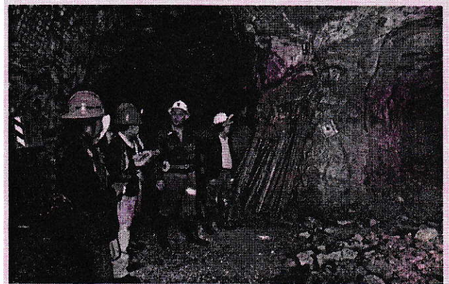
H.6. Đường hầm chống vì neo BTCT có phụ gia đông cứng nhanh của Công ty TNHH khai thác Vàng Bông Miêu [2]
