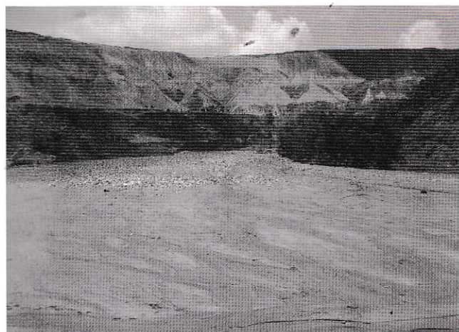
H.2. Sạt lở bãi thải Đông Cao Sơn sau mưa lũ
