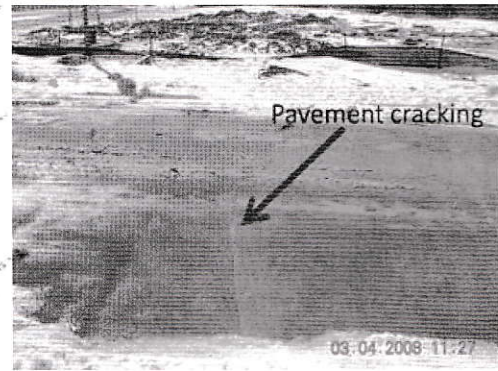
H.5. Một số dạng sự cố khi thi công CTNTDN [11]: a - Lún, sụt đường; b - Nứt mặt đường
