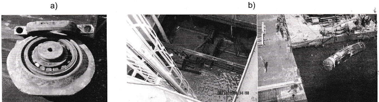
H.7. Sự cố đĩa cắt và ngập lụt tại giếng thi công: a - Hồng đĩa cắt [12]; b - Ngập lụt trong các giếng [13]
