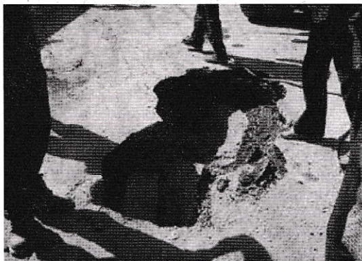
H.5. Một số dạng sự cố khi thi công CTNTDN [11]: a - Lún, sụt đường; b - Nứt mặt đường
