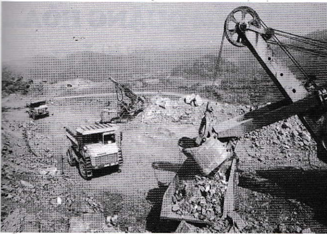
Ảnh 3. Máy khoan TAMROCK và máy xúc điện gầu ngược [7]
