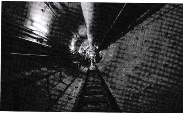
H.12. Kết cấu chống bằng bê tông cốt thép khi thi công CTN bằng MĐH [6]
