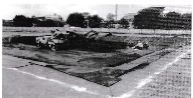
H.11. Một số hình ảnh thi công thử nghiệm đắp chồng cao bãi chứa bùn đỏ khô
