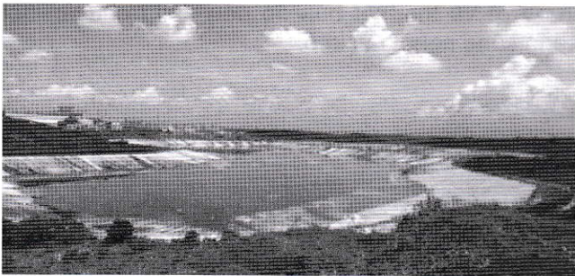
H.4. Khoang chứa bùn đỏ số 1 tại Nhân Cơ
