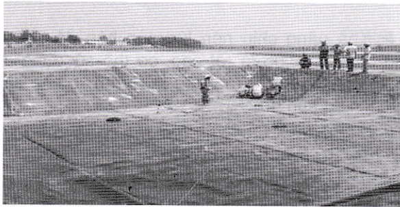
H.10. Mặt bằng và mặt cắt thử nghiệm đắp chồng bùn đỏ khô
