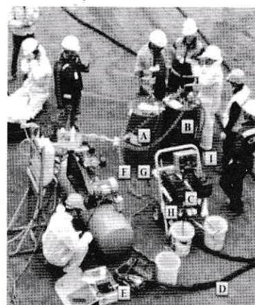
H.3. Vật liệu phun, thiết bị phun điển hình và máy phun Titan Helix VR 2.3: A - Thùng chứa thành phần A (Iso); B - Thùng chứa thành phần B (Poly); C - Bộ nạp lò phản ứng (nơi đặt máy bơm cao áp có bộ phận gia nhiệt được sử dụng để cung cấp nguyên liệu A và B); D - Vòi nóng (ống lắp đặt thiết bị gia nhiệt được sử dụng để duy trì nhiệt độ thích hợp của các thành phần từ thiết bị tới súng phun); E - Súng phun (thiết bị trộn lẫn các thành phần A và B và sau đó phun ngay lên bề mặt ở áp suất rất cao); F - Ống cung cấp không khí (ống cung cấp không khí từ máy nén khí cho máy bơm và máy khuấy); G - Ống cung cấp các thành phần A và B cho bộ cấp liệu phản ứng; H - Ống tuần hoàn (được sử dụng để di chuyển các thành phần A và B xung quanh thiết bị gia nhiệt); I - Mô đun điều khiển chính của thiết bị [7].
