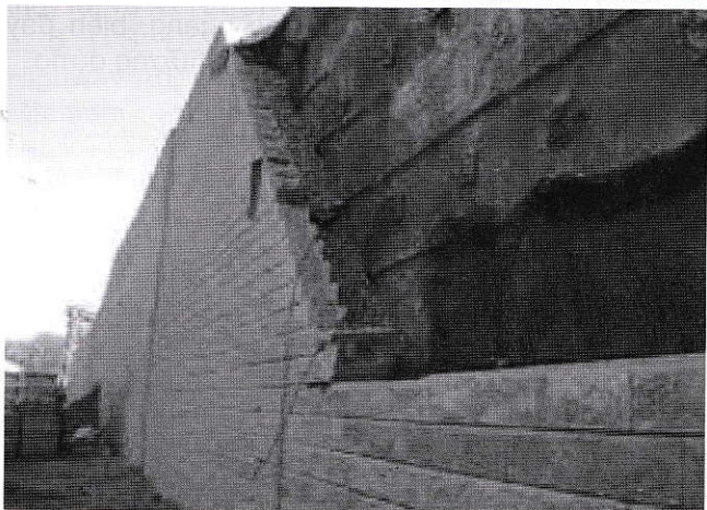
H.8. Thi công mặt ngoài cùng tường Neo
