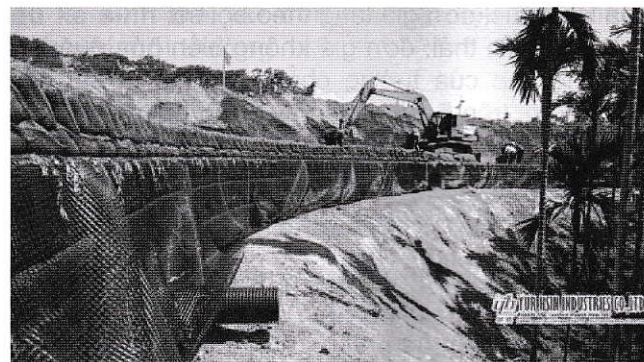
H.4. Đóng và xếp bao tải đất và điều chỉnh mặt bằng
