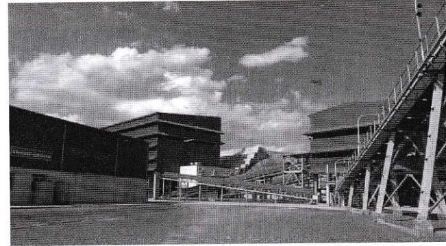
H.5. Nhà máy tuyển quặng bauxit Nhân Cơ-Đắc Nông
