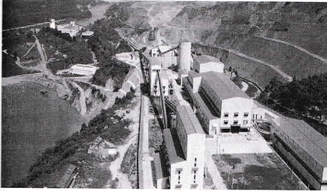
H.6. Toàn cảnh Nhà máy tuyển số 2
