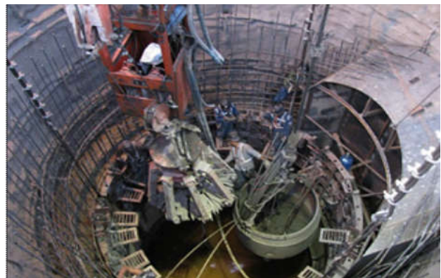
H.2. Gầu nhót HZ-6 và thùng trực thi công giếng đứng Hà Lâm
