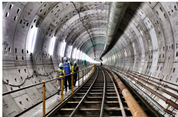
H.7. Hình ảnh đường hầm nối giữa hai ga Ba Son và Ga Nhà Hát lớn tuyến metro số 1 Tp. Hồ Chí Minh sau khi thi công và lắp đặt kết cấu chống.
