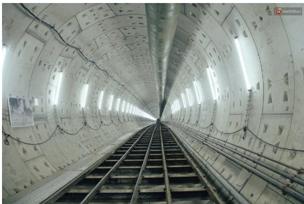
H.7. Hình ảnh đường hầm nối giữa hai ga Ba Son và Ga Nhà Hát lớn tuyến metro số 1 Tp. Hồ Chí Minh sau khi thi công và lắp đặt kết cấu chống.
