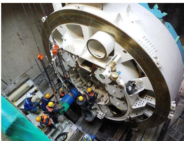
H. 6. Hình ảnh quá trình lắp đặt và thiết bị bên trong Máy khoan đào tuyến số 1 tại Tp. Hồ Chí Minh: a - Quá trình lắp đặt đầu đào; b - Bên trong máy
