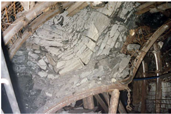
c. Gia cường phục vụ chống xén lò
