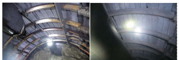
H.5. Lắp thử nghiệm tấm chèn lò EPS-C
