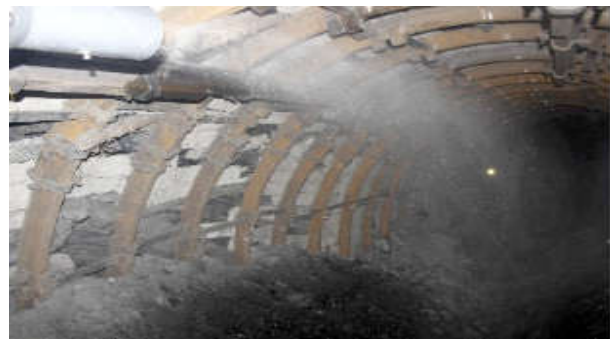
H.5. Chống bụi bằng tổ hợp ejectơ sử dụng vòi phun tia chùm tại gương lò đá mức -300 V7 khu I - Công ty than Hà Lâm
