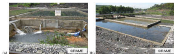
H.4. Đầm lầy nhân tạo trong giai đoạn thi công các ngăn (a) và sau khi hoàn thành (b)
