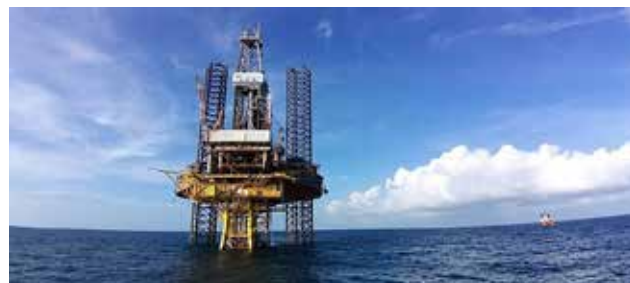
H.6. Giàn nhẹ không người (unmanned) BK-20 ở mỏ Bạch Hổ, Lô 09-1 bể Cửu Long
