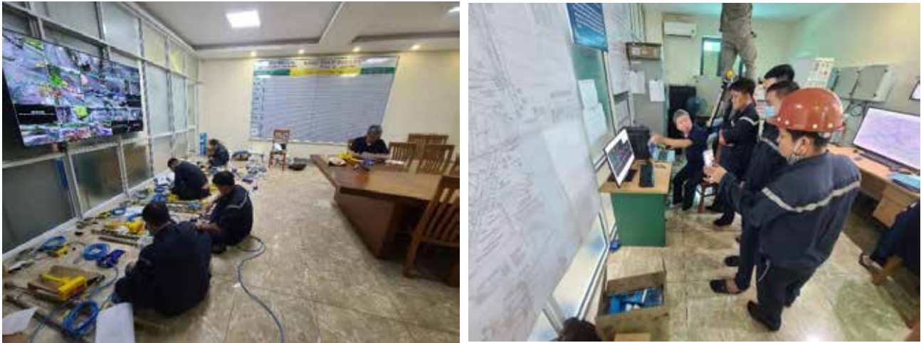
H.7. Một số hình ảnh lắp đặt hệ thống quan trắc KJ520
