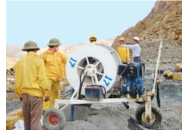
c, Bơm tháo nước
