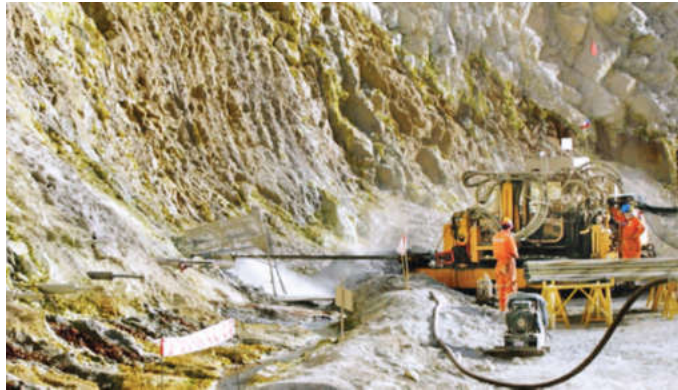
a, Khoan tháo nước tại chân tầng [9]
