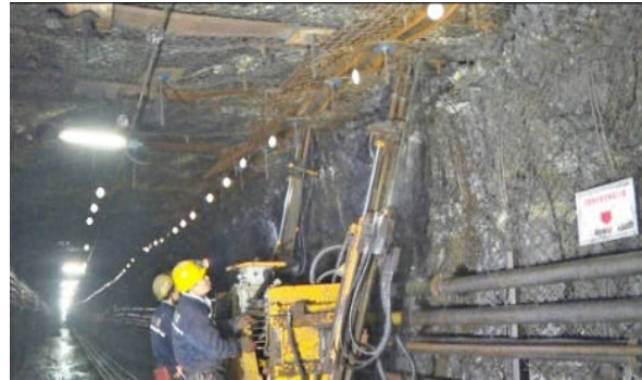
Hình 8. Công tác khoan nổ mìn cắt vách định hướng
