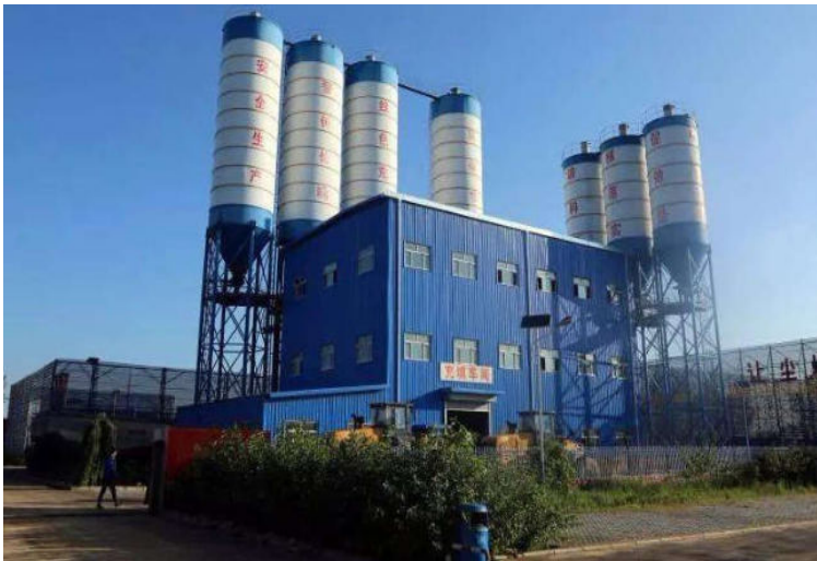
a. Trạm trộn vữa chèn trên mặt bằng.
