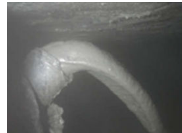
b. Thi công chèn.
