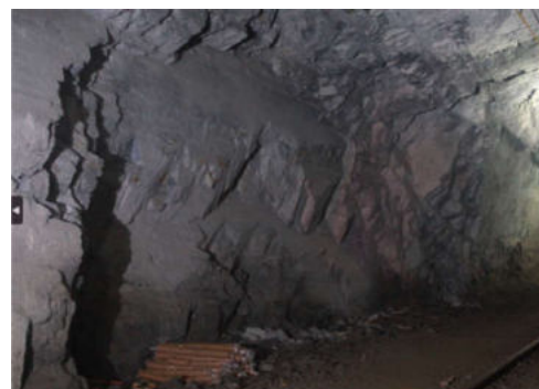
b) Đường lò dọc vỉa +70
