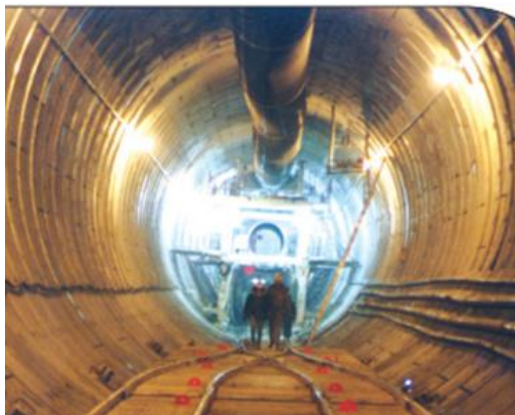
a) Vỏ chống đúc sẵn cho đường hầm xây dựng dưới sông St. Clair giữa Sarnia, Ontario và Port Huron, Michigan, Hoa Kỳ [4]
