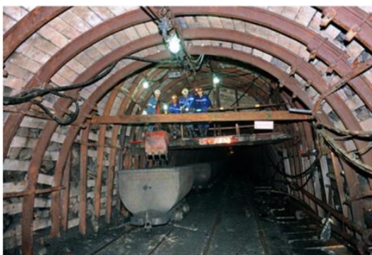
Hình 2. Hình ảnh tấm chèn bê tông cốt thép sử dụng thực tế (a); mô hình tính tấm chèn (b) và sơ đồ tải trọng đất đá tác dụng lên tấm chèn (c)
