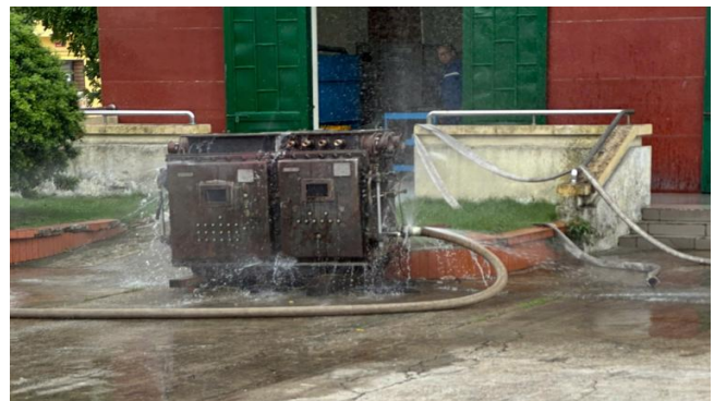
Hình 10. Hình ảnh thử áp lực nước của vỏ tủ
